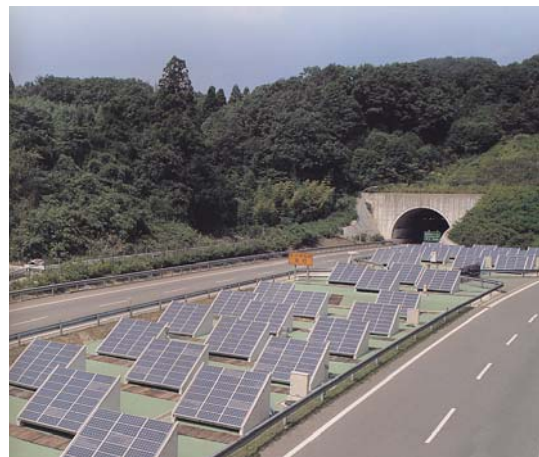
7号北神戸線・長坂山トンネル坑口付近
