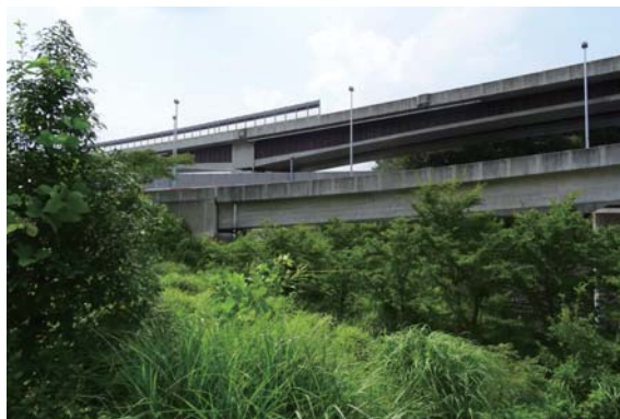
西宮山口南出口(ループ内)ビオトープ
