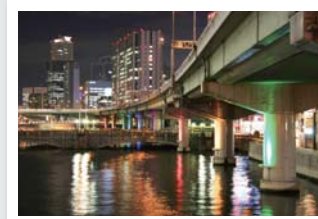
堂島川橋脚ライトアップ開始(2008年)
