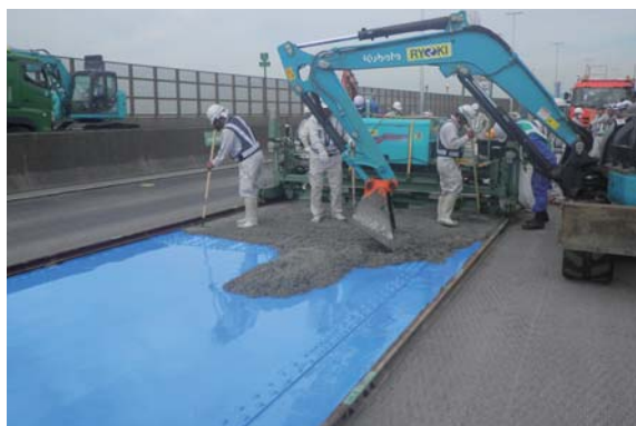
SFRC舗装による鋼床版の耐久性向上のイメージ図
