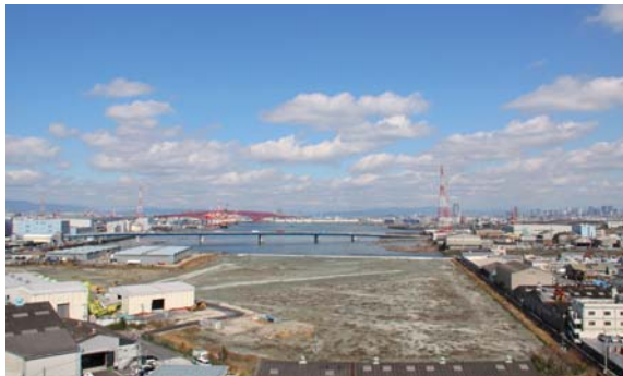
埋立状況(2016年1月撮影)
