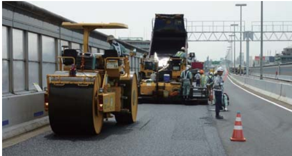
舗装工事風景
