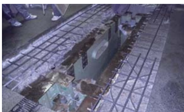
既設伸縮装置(ジョイント部)の撤去
