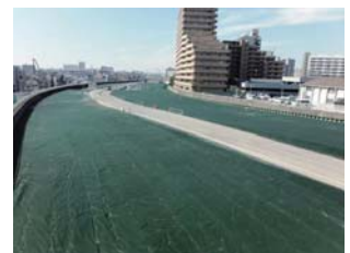
防草シート保護養生完了 (森巣橋付近)
