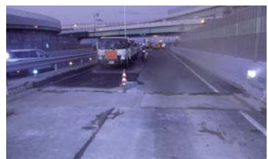
コンクリート床版の連結
