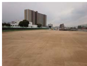
公園用良質土敷均し完了 (森巣橋上流側付近)
