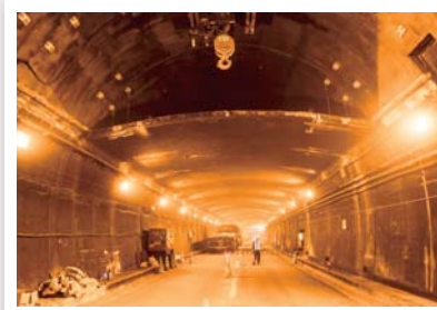
天井板撤去前
