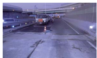
コンクリート床版の連結
