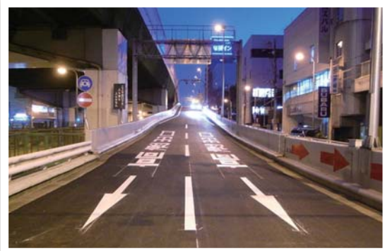
出口誤進入防止対策 扇町出口
