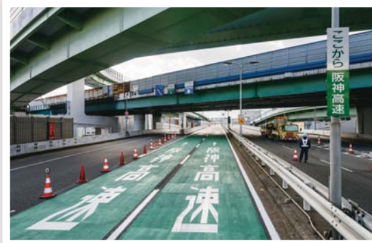
原付誤進入防止対策 守り入口(寝屋川バイパス直結部)
