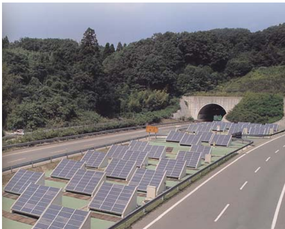
7号北神戸線・長坂山トンネル坑口付近
