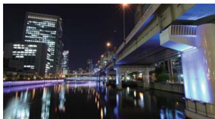
堂島川の橋脚 ライトアップ
