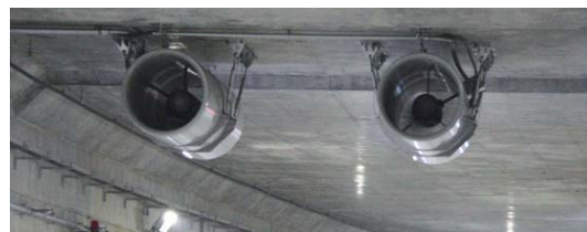
インバータ制御ジェットファン
