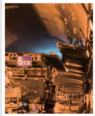
多軸台車による撤去作業
