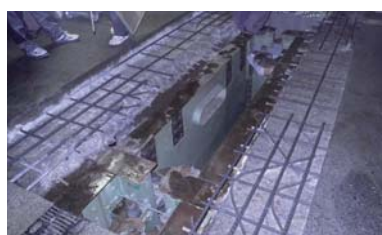
既設伸縮装置(ジョイント部)の撤去
