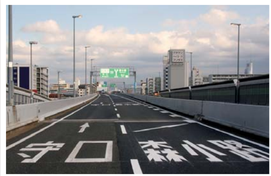
路面への行先表示と超高輝度反射型道路案内標識 森小路分岐付近
