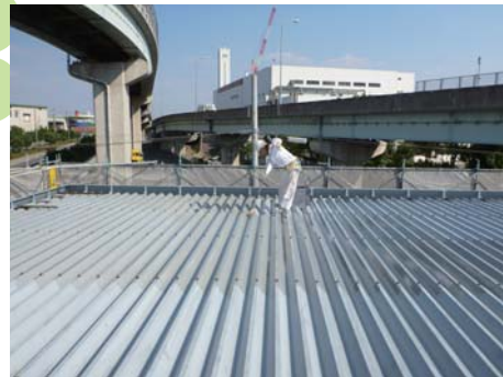
基地屋根への熱交換塗装
