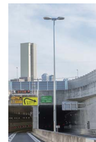
2号淀川左岸線の高架道路用照明
