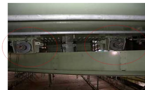
写真-2 ゲルバー支承部の落橋防止装置
