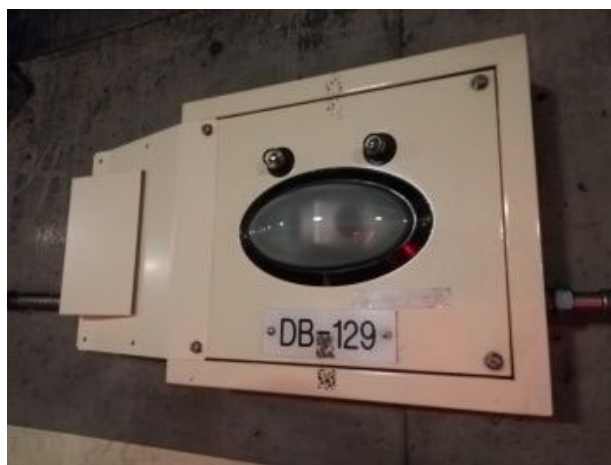
図-5 火災検知器ダクト設置状況
