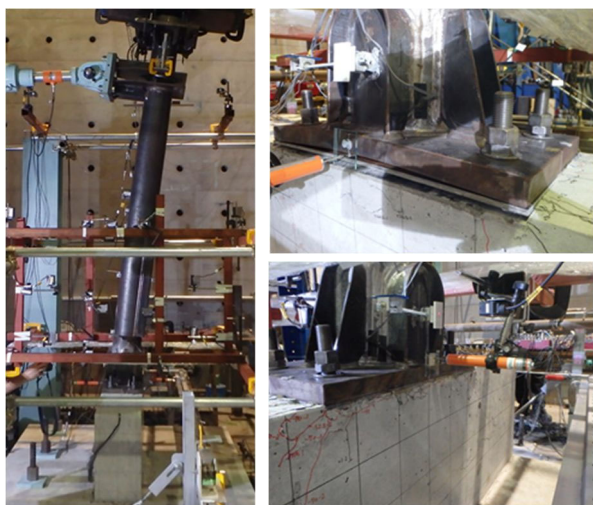
写真-4 最大荷重時の照明柱 (左: 全景, 右上: 基部(引張側), 右下: 基部(圧縮側))
