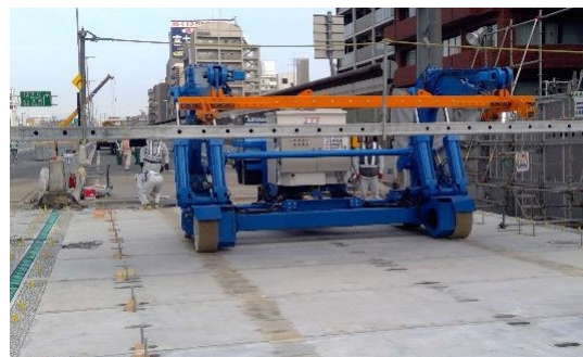
写真-6 アーム式専用架設機によるUFC床版の架設
