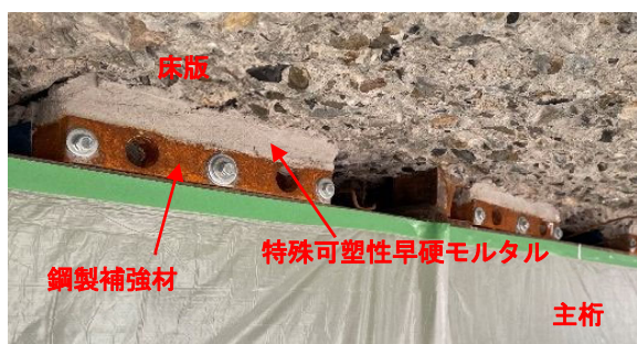
写真-1 仮補強材の設置状況
