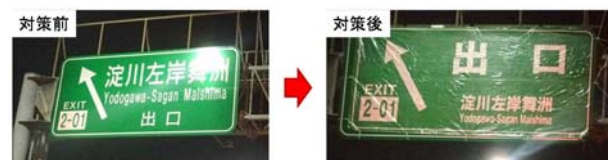
図-6 対策前後の淀川左岸舞洲出口分岐案内標識
