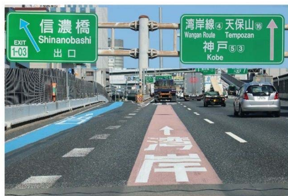
信濃橋出口と西船場JCTの現況
