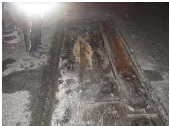
(a) 鋼床版上面より
