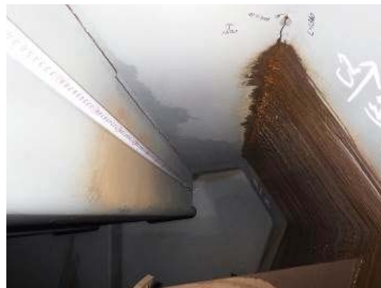
(b) 箱桁内部より
