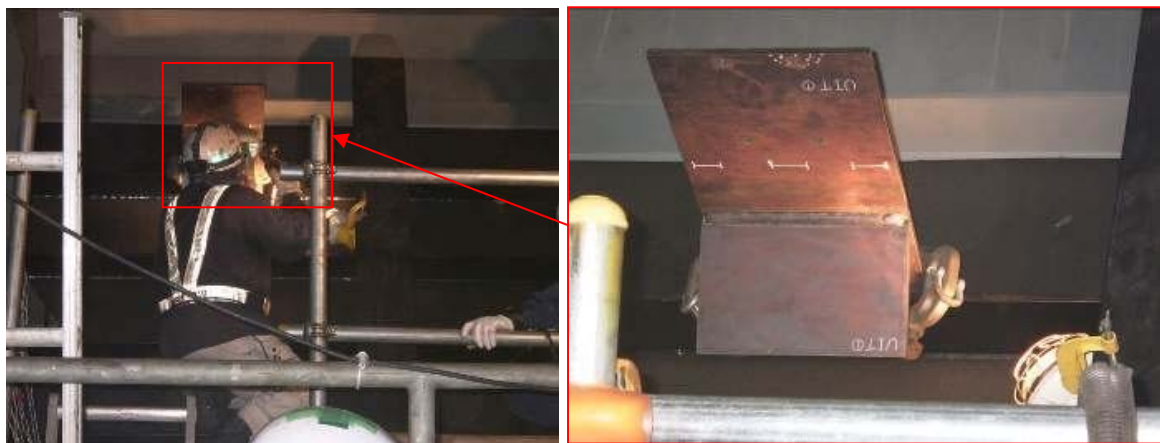
図-3 箱桁内における試験体に対するピーニング施工例
