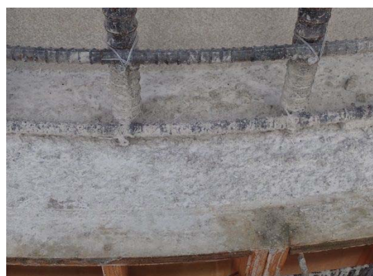
写真-2 有機繊維補強 Co 近景
