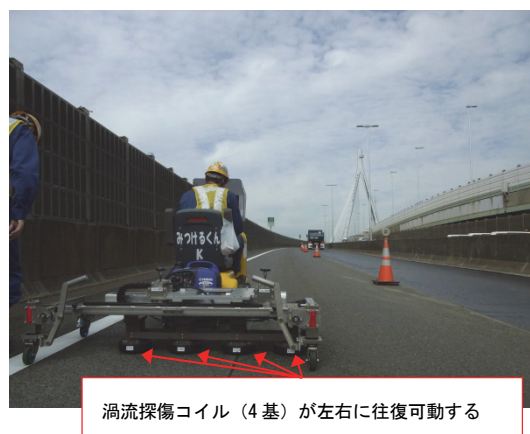
図-3 鋼床版検査装置による検査の状況
