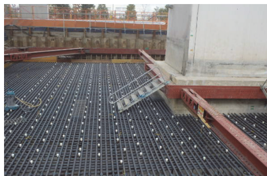
写真-11 Ccb(白く見えるのがセラミック定着体)と増厚部配筋状況
