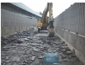
写真-2 舗装撤去
