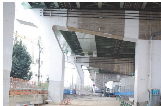
写真-9 外ケーブル補強完成状況
