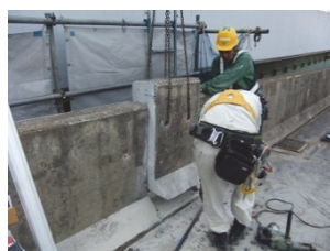
写真-3 壁高欄撤去
