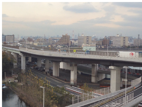
写真-6 再利用桁を含む鋼桁の完成状況
