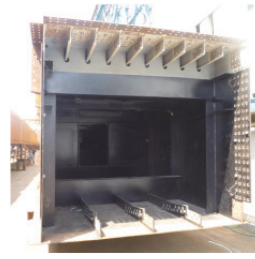
写真-4 箱内状況
