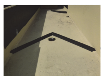
写真-5 排水設備追加
