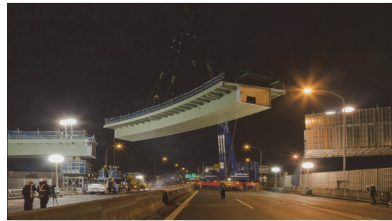
写真-4 550tオールテレーンクレーンによる架設状況
