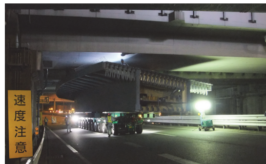
写真-5 鋼桁運搬状況
