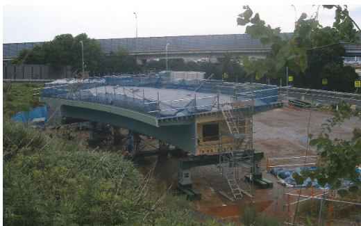
写真-6 仮組立状況
