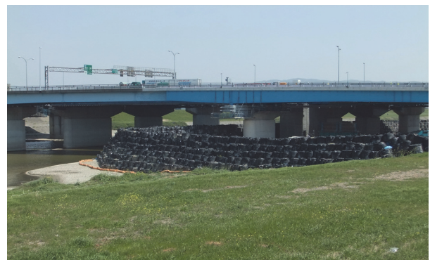
写真-1 大和川河川半川締切状況
