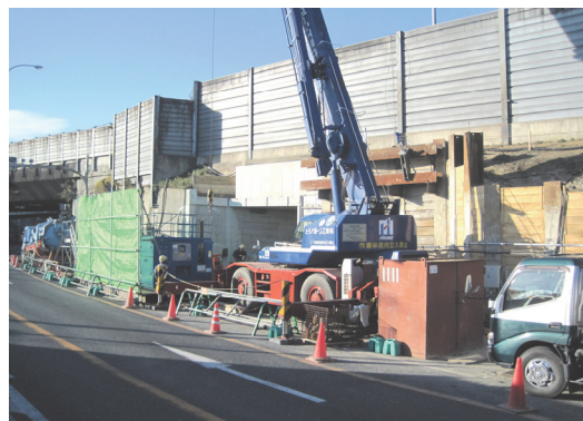
写真-3 GP4 地盤改良施工状況
