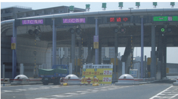
図-6 案内看板設置状況（南芦屋浜集約料金所）
