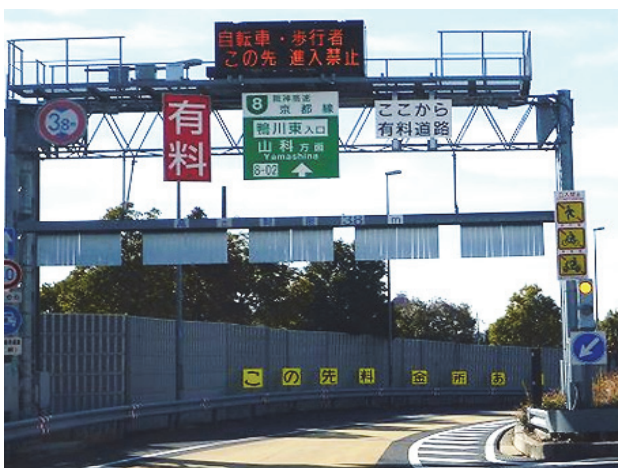
図-2 進入間違いに気付かせることに注力した水際対策 (8号京都線 鴨川東入口)
