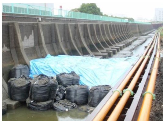
写真-2 土堰堤設置状況
