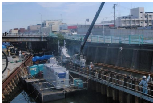
写真-3 鋼矢板打設状況
