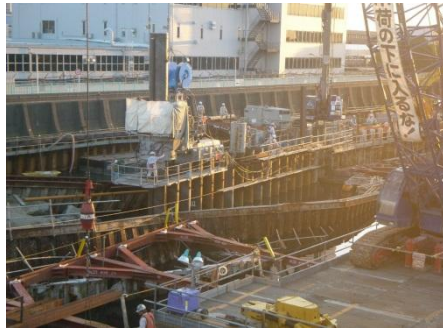
写真-6 鋼管矢板打設状況
