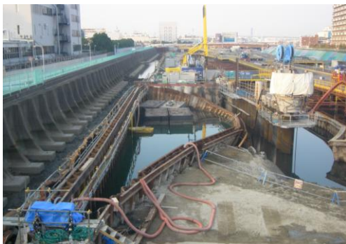
写真-4 鋼矢板打設完了後
