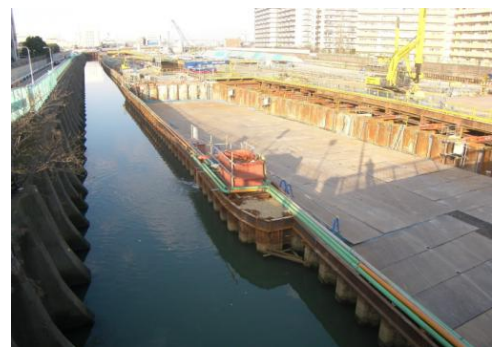
写真-5 仮水路復旧完了後
