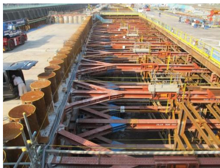
写真-7 土留支保工復旧完了後
