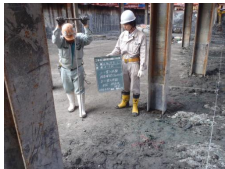
写真-8 床付面の現地確認状況
