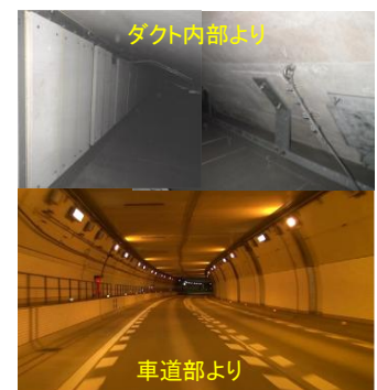
写真-1 天井板設置状況
