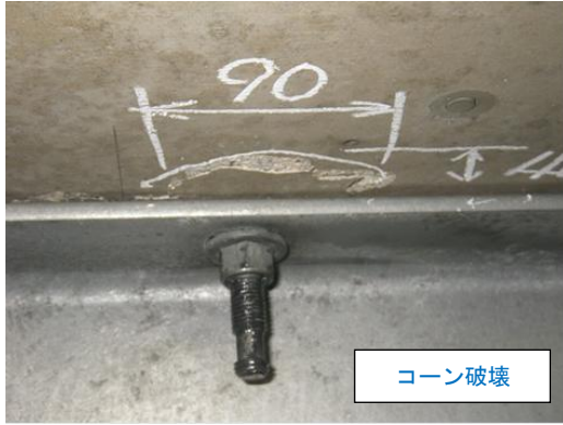
写真-3 引抜試験結果(破壊状況)
