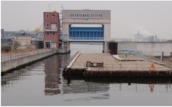
写真-1 正蓮寺川水門
