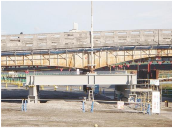
写真-4 横断橋梁仮受
