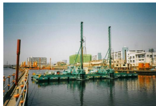
写真-2 浅層改良工（原位置で機械攪拌）
