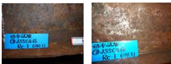
写真-3 2種ケレン前後の鋼材表面（試験範囲B）
