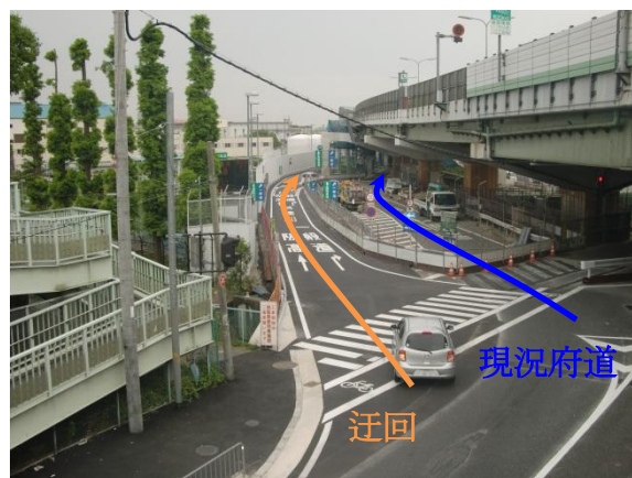
写真-3 Bランプ守口線拡幅部施工状況
