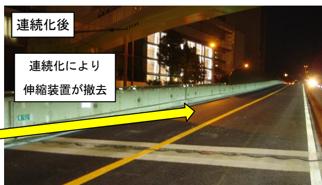
写真-7 連続化による伸縮装置撤去状況
