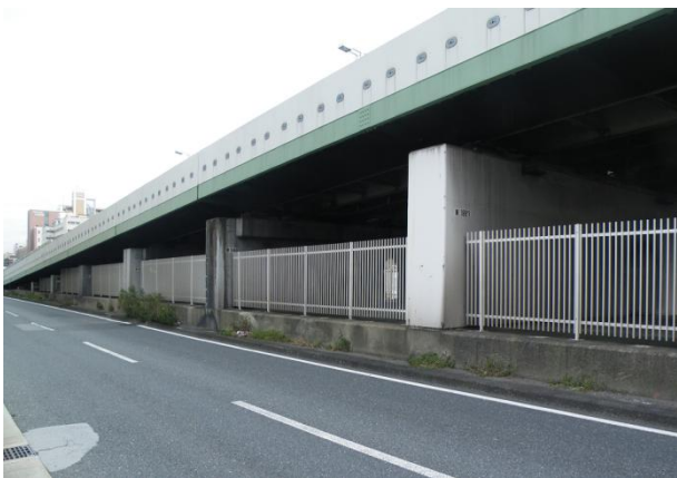
写真-2 法円坂区間外観写真
