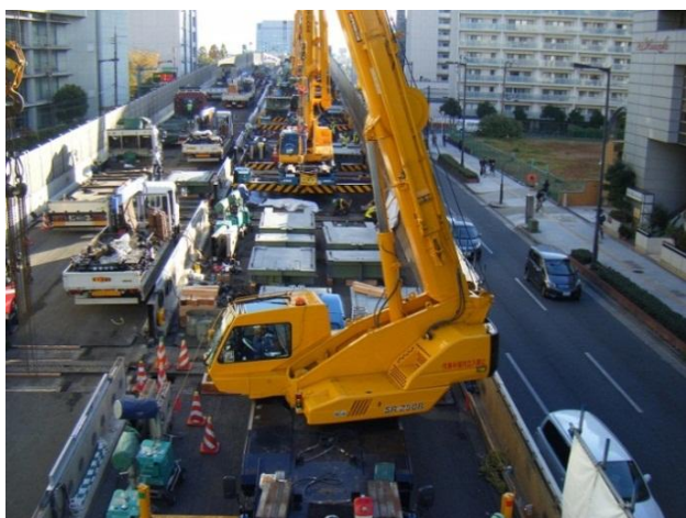
写真-5 ラフタークレーン設置状況
