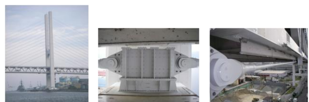
(a) 全景 (b) 積層ゴムダンパー (c) ケーブル
