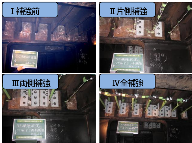
写真-1 計測段階と補強状況
