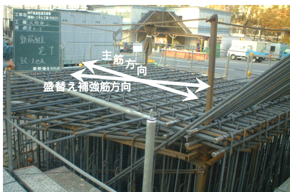
写真-1 施工性試験供試体
