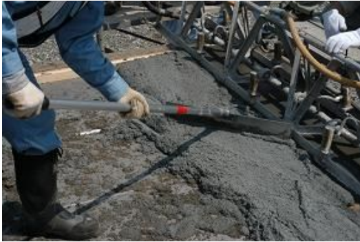
図-2 ポリマーセメントモルタル打設状況
