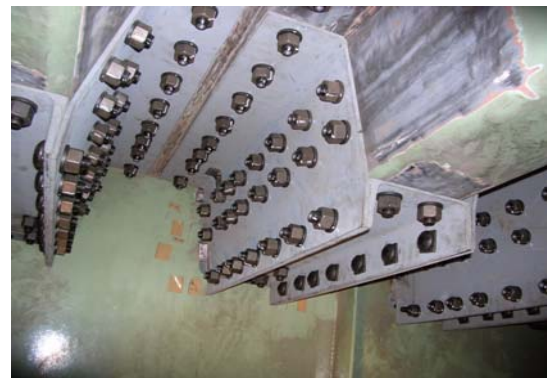
(b) デッキプレート下面の側面板
