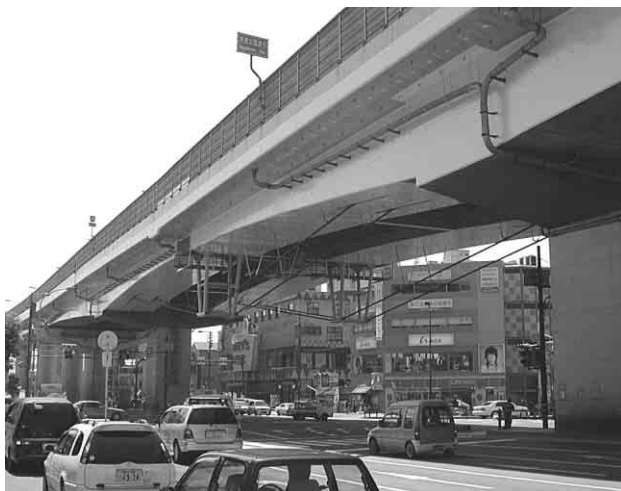
写真-1 喜連瓜破高架橋全景写真
