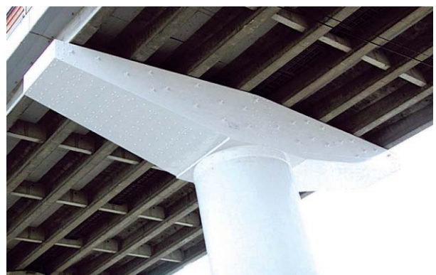
写真-14 補修完了状況
