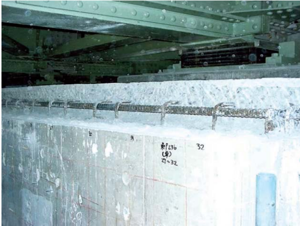
写真-2 はつり調査状況（梁天端）の例
