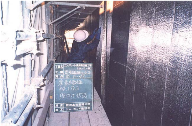
写真-15 炭素繊維シート巻き立ての施工状況
