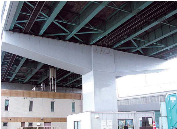
写真-16 炭素繊維シート巻き立て補修橋脚
