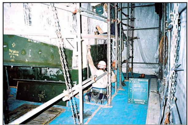
写真-13 鋼板取り付け状況
