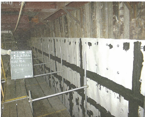
写真-1 ベントナイトシート施工状況
