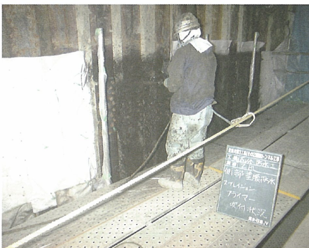
写真-2 塗膜系施工状況
