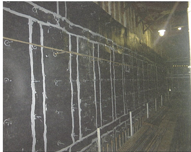
写真-3 合成ゴムシート施工状況
