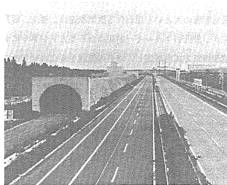
図-2 トンネル全景
