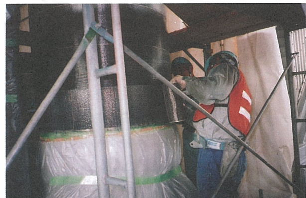
写真-3 炭素繊維シートへのエポキシ樹脂含浸（周方向）
