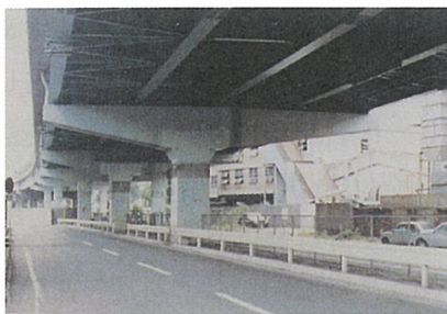
図-2 補修後橋脚
