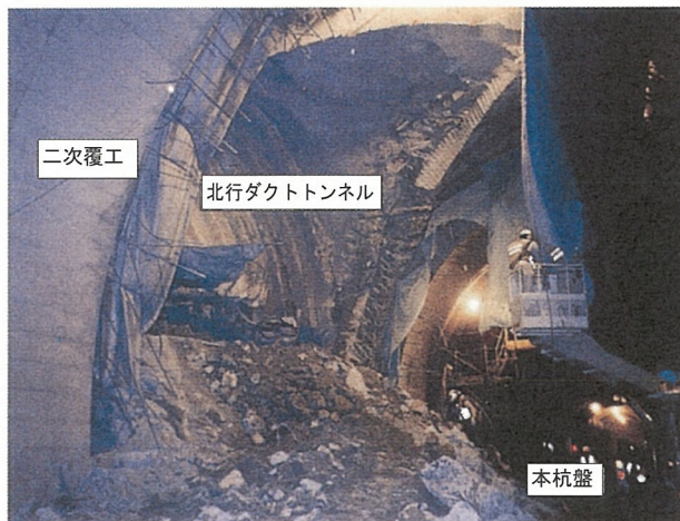
写真-3-2 交差部開口状況 (本坑側より)
