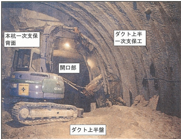
写真-3-1 交差部開口状況 (ダクト側より)
