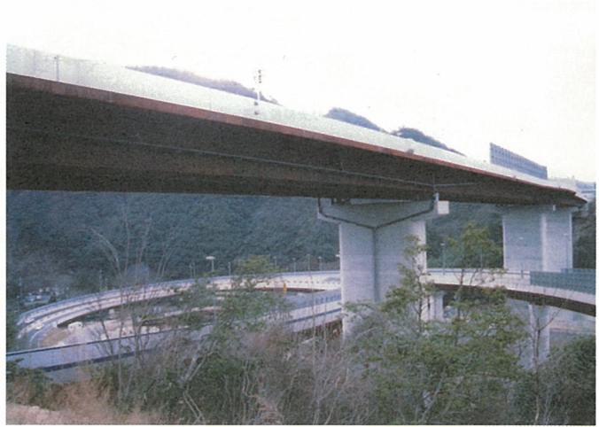
図-9 北神戸線無塗装耐候性橋梁の建設地点 写真-1 無塗装耐候性橋梁の一例(北神戸線・有野五社橋)
