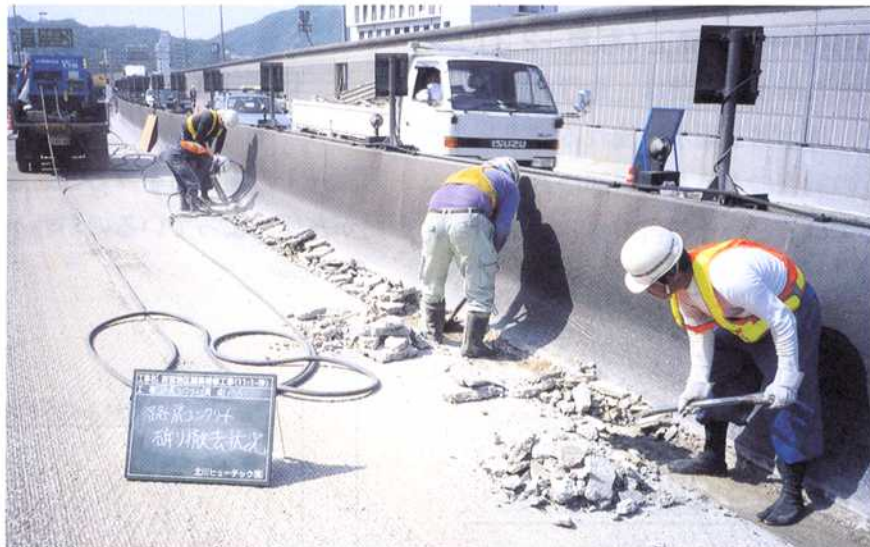
写真-2 路肩コンクリートはつり状況
