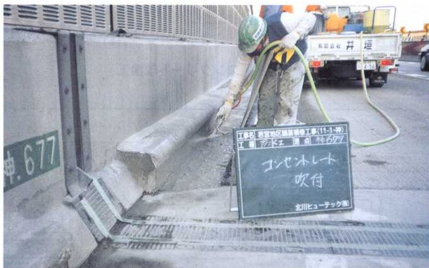
写真-3 防水工施工状況
