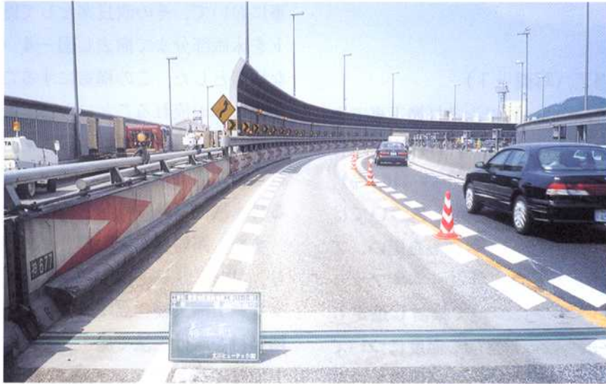
写真-1 施工状況（左車線：施工前 右車線：施工後）
