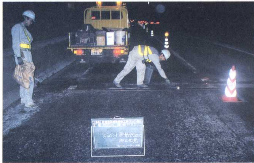
写真-4 骨材飛散防止樹脂塗布状況
