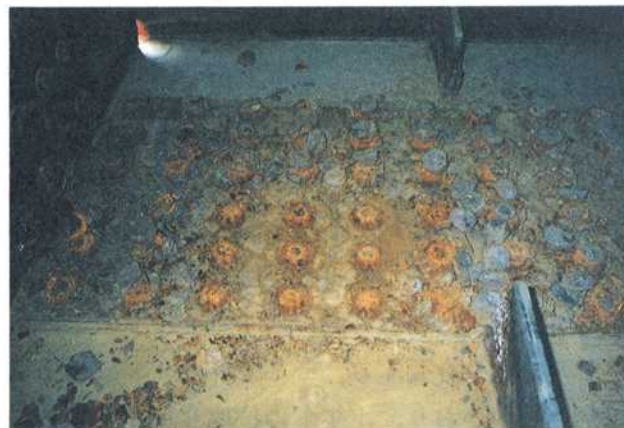
写真-1 Aランクにおける発生錆の状況
