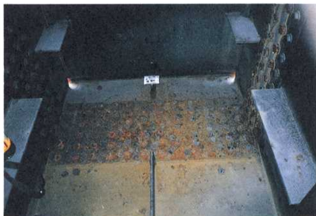
写真-1 Aランクにおける発生錆の状況
