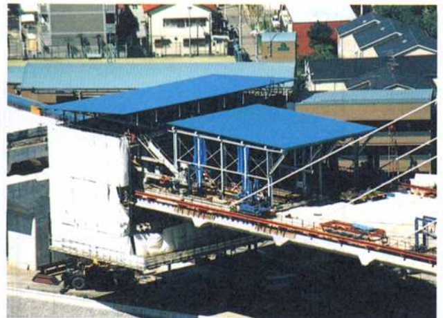
写真-2 主桁架設状況
