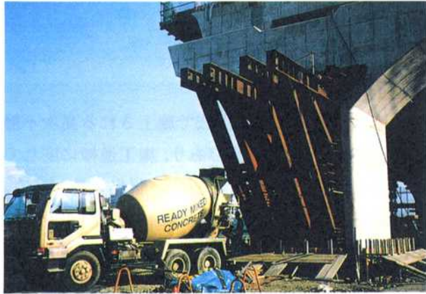
写真-3 ブラケット式制振工
