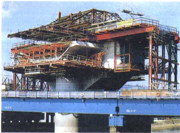
写真-1 柱頭部施工状況
