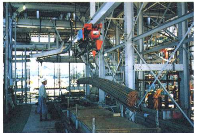
写真-5 鉄筋運搬台車
