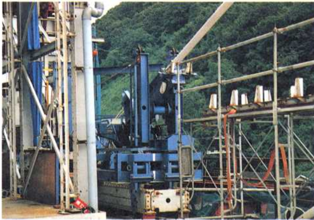
写真-6 斜材引込装置
