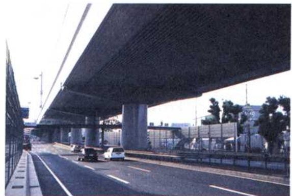
写真-1 完成写真
