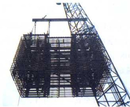
写真-1 主塔鉄骨架設状況
