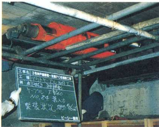
写真-3 外ケーブル緊張状況
