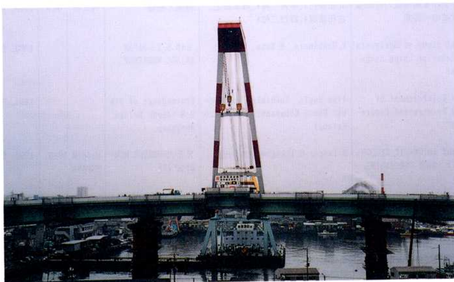
湾岸線最終区間（春木川大橋）結合式
