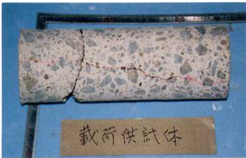
図-12 コア採取によるひびわれ状況確認
