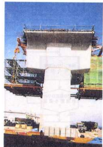
写真-1 柱頭部施工状況
