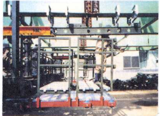
写真-2 伸縮台車によるレール取付状況
