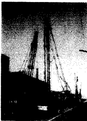
写真-1 地盤改良工小断面連壁：中島
