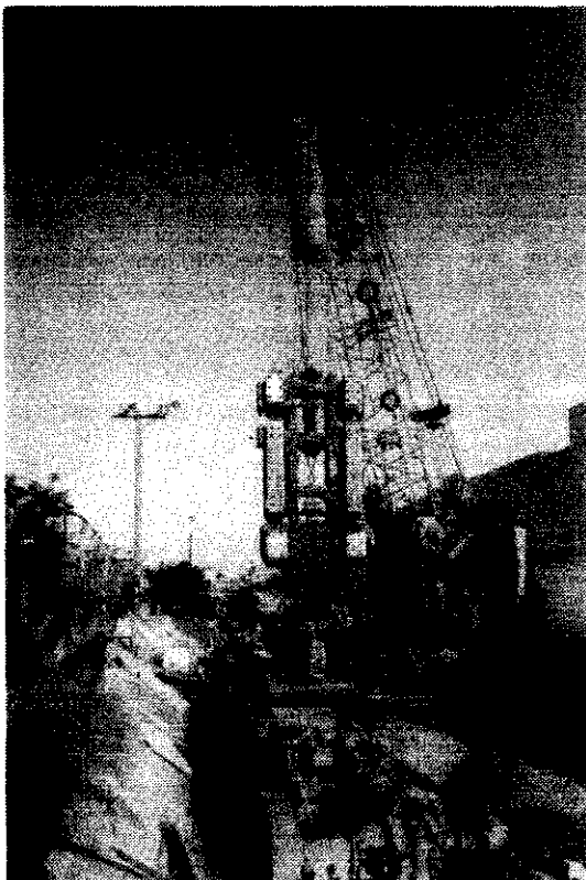
写真-2 掘削機小断面連壁 中島
