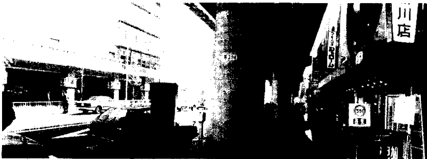
写真-14 柱（橋脚）の巨大さが目につく現況
