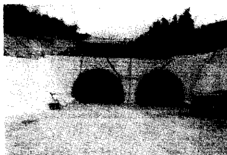
トンネル完成
