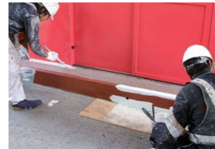
料金所アイランド塗装(左) / 料金所ブース樹脂ガラスの入れ替え(中) / 料金所ブース建具の補修(右)
