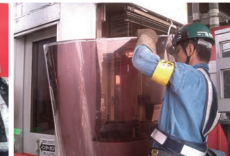
料金所アイランド塗装(左) / 料金所ブース樹脂ガラスの入れ替え(中) / 料金所ブース建具の補修(右)
