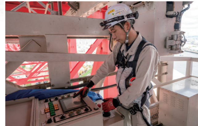
長大橋橋梁点検台車の走行確認
