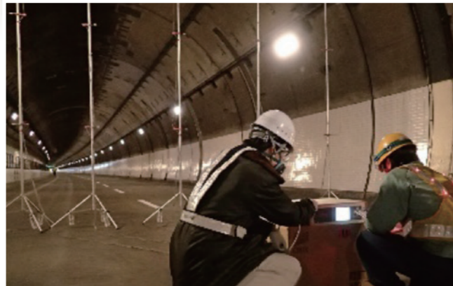
ジェットファン昇圧力測定
