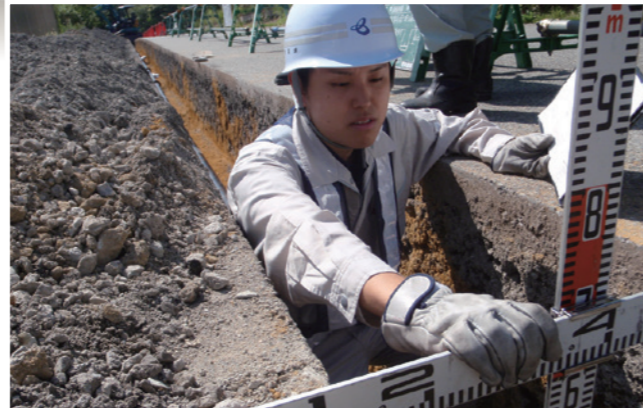
配管埋設深さ確認
