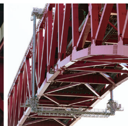
B 下面足場
