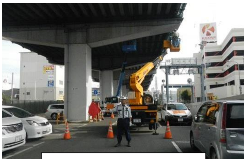
鋼本体の錆片のたたき落とし・防錆処 置を実施
