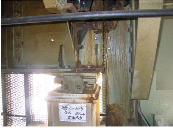
環状線 鋼桁端部さび・腐食（補修前） 環状線 鋼桁端部さび・腐食（補修後）
