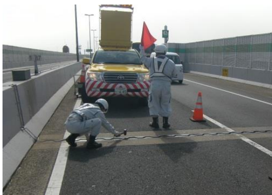
日常点検（路上）
