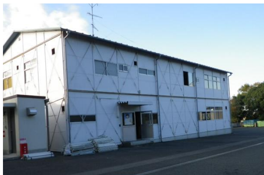
前開凍結待機所（改築前）
