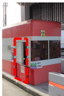
料金自動收受機設置前
