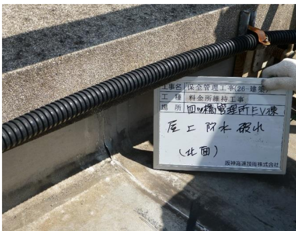
点検実施状況
