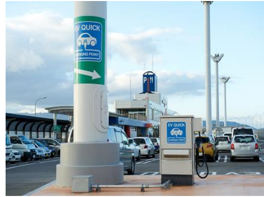
電気自動車急速充電器設置
