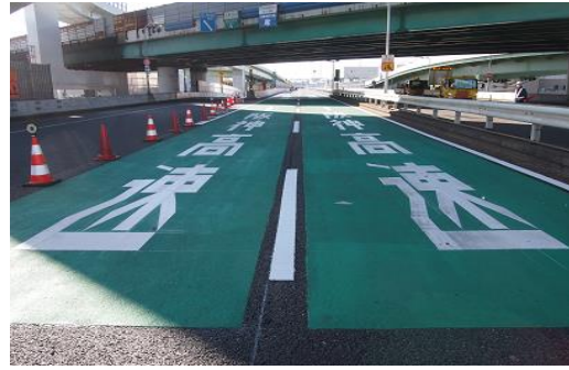
カラー舗装の設置 (12号守口線 守口入口(寝屋川B.P))
