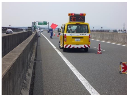
構造物日常点検時の支援（交通規制）
