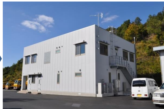
前開凍結待機所（改築後）
