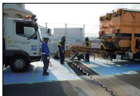
②舗装敷設後、ジョイントを施工
