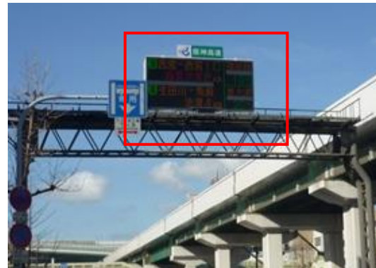
道路情報板取替後
