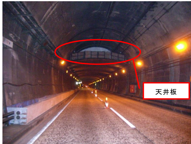
32 号新神戸トンネル天井板（撤去前）
