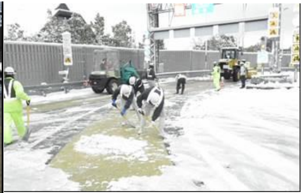
除雪状況 (人力)
