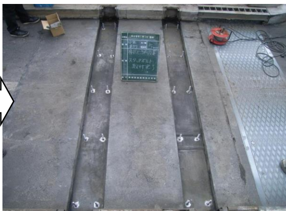
軸重計棒状センサー補修後
