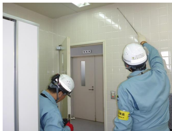
点検実施状況
