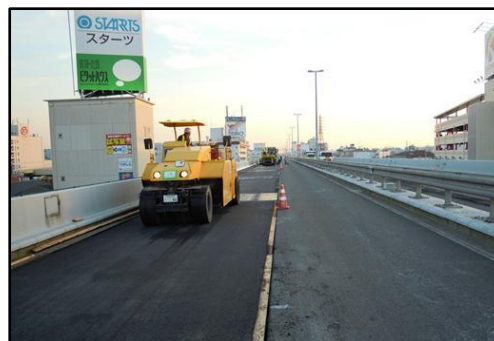
①橋梁間を連続で舗装
