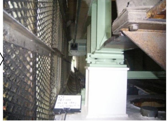
環状線 鋼桁端部さび・腐食（補修前） 環状線 鋼桁端部さび・腐食（補修後）
